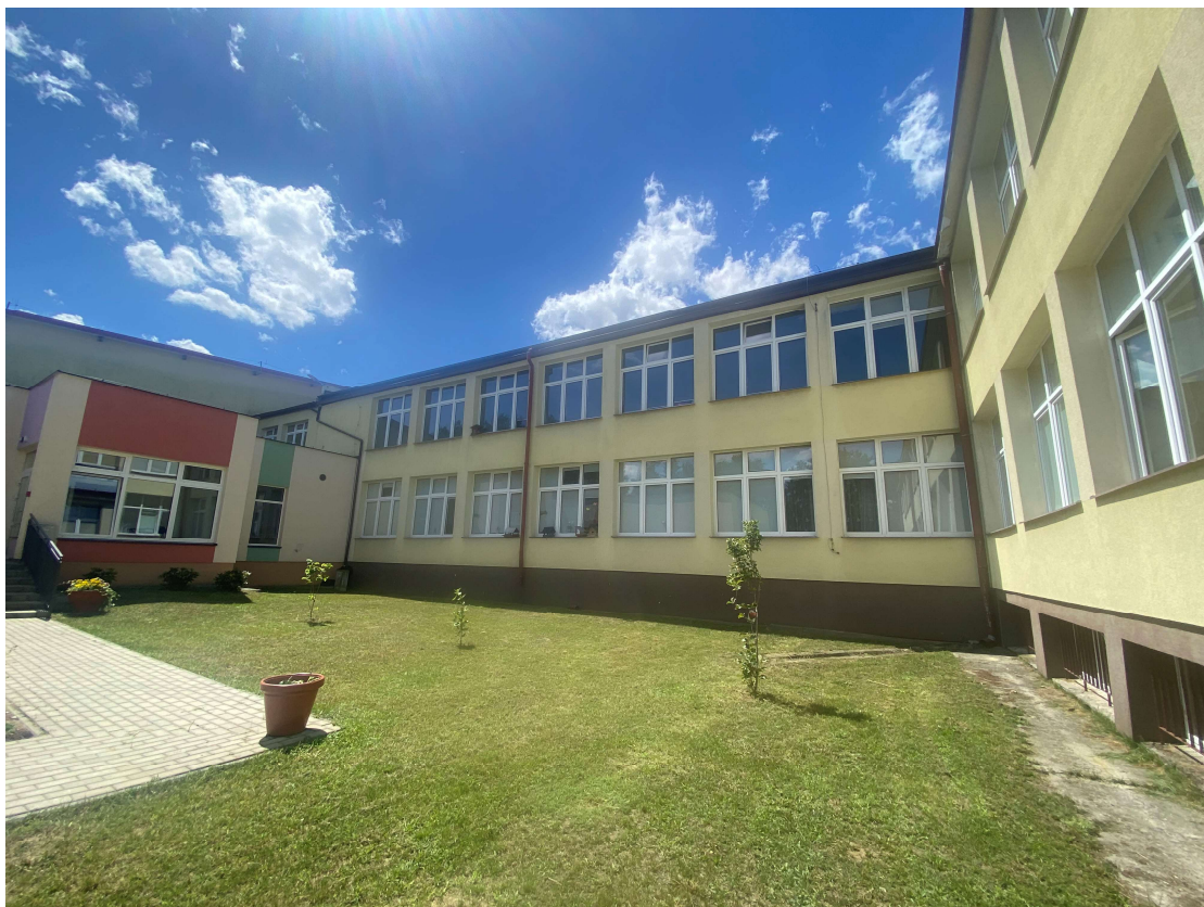
elewacja wschodnia – część „stara” dydaktyczna
