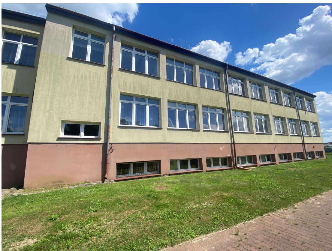
elewacja zachodnia - część „nowa” - kuchnia
