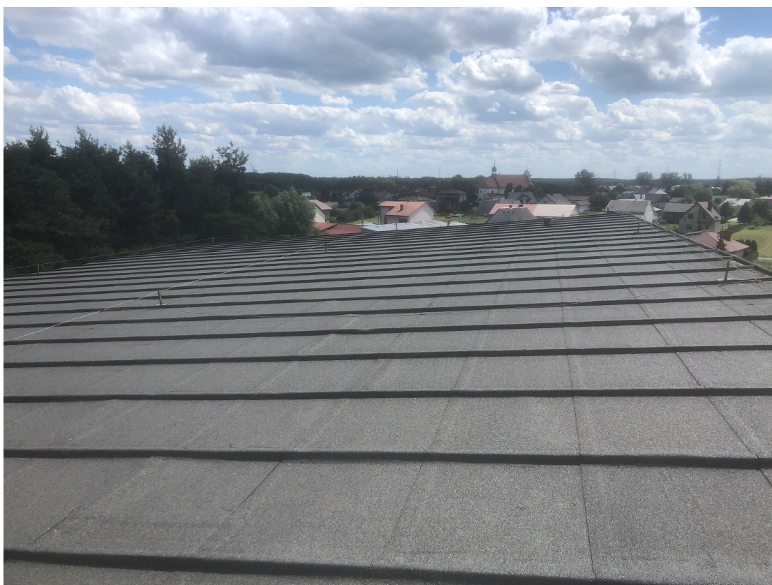
dach nad salą gimnastyczną
