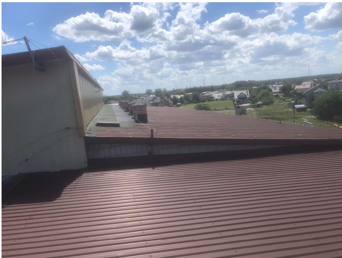
dach nad zapleczem sali gimnastycznej część „nowa”
