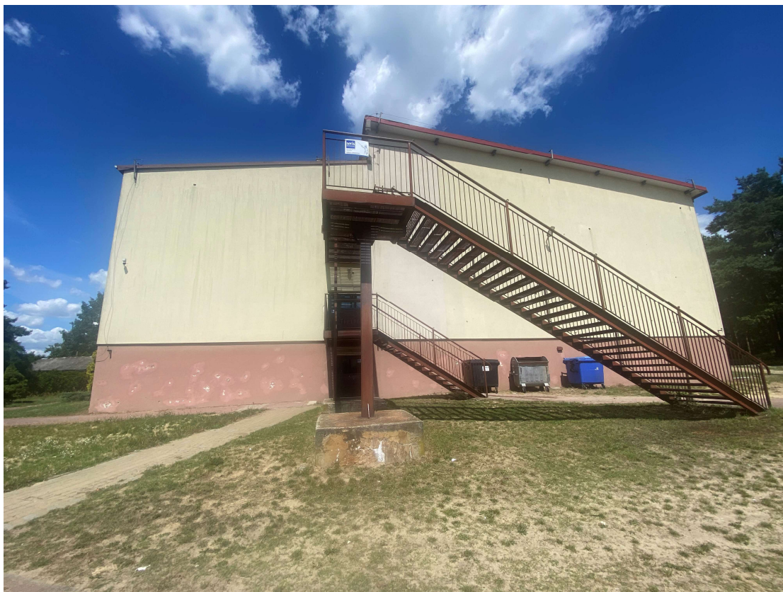
elewacja południowa – zaplecze i sala gimnastyczna
