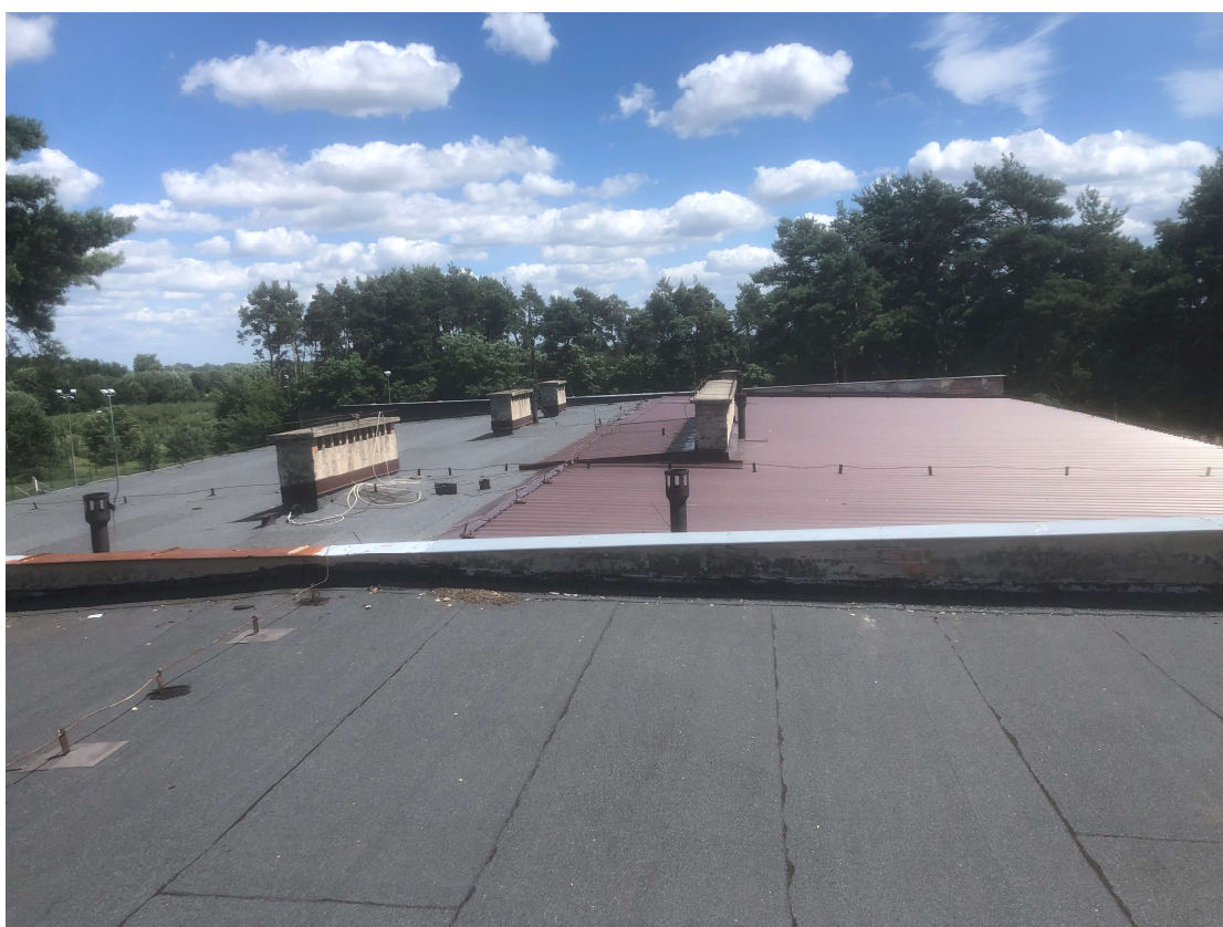
dach w części „starej” dydaktycznej od strony wschodniej
