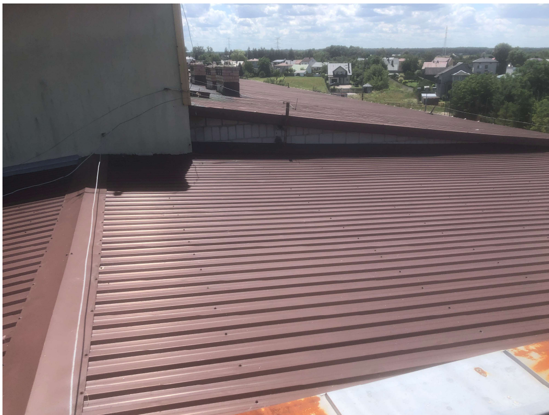
dach nad łącznikiem
